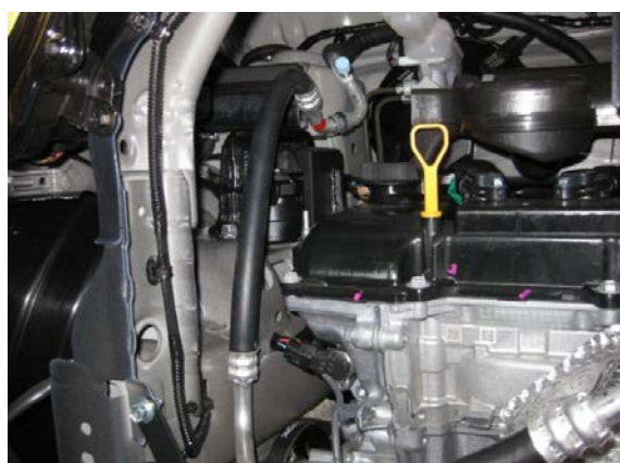
エアコンパイプの曲げ加工例
